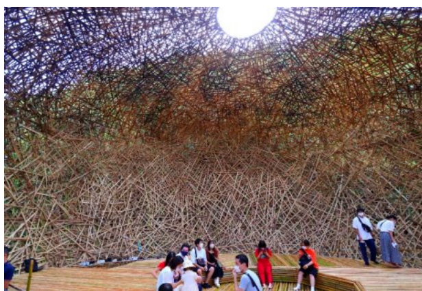
小豆島 「ゼロ」ワン・ウェンチー（台湾）直径15mのドームは4000本の竹を編み込む構造。
