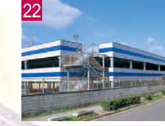
22 駐車場 2階3層構造の立体駐車場。約500台収容できます。申請により、車での通学が可能となります。
