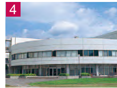
4 光風館(7号館) 主に社会学部の講義が行われる建物です。
