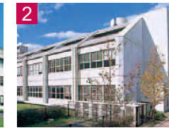
2 栄光館(4号館) 主に文学部の講義が行われる建物です。
